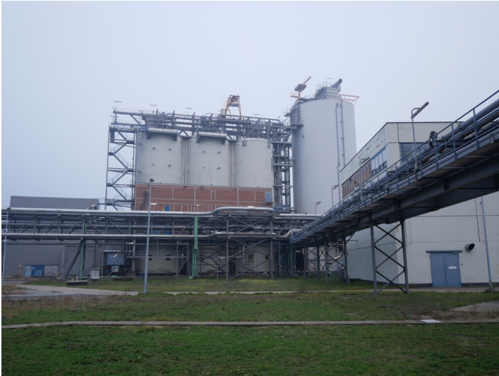
Kraftwerk Jänschwalde Aschebunker (2022) Fotograf/Urheber: Alexandra Krug
