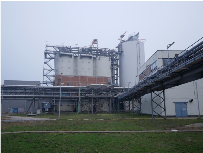
Kraftwerk Jänschwalde Aschebunker (2022) Fotograf/Urheber: Alexandra Krug
