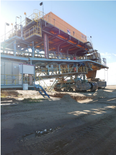
Bandantriebsstation Kohleabbau Fotograf/Urheber: Franz Dietzmann
