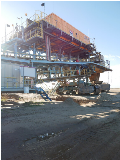
Bandantriebsstation Kohleabbau Fotograf/Urheber: Franz Dietzmann
