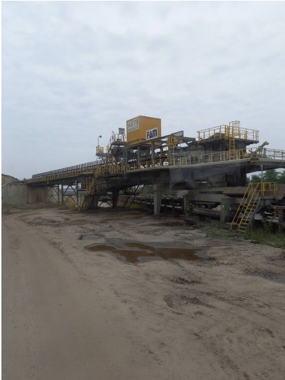
Antriebsstationen Kohleband Fotograf/Urheber: Marie Mamerow
