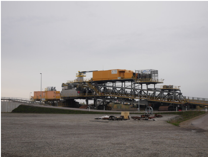
Bandantriebsstationen Neue Kohleverladung Fotograf/Urheber: Tanja Trittel
