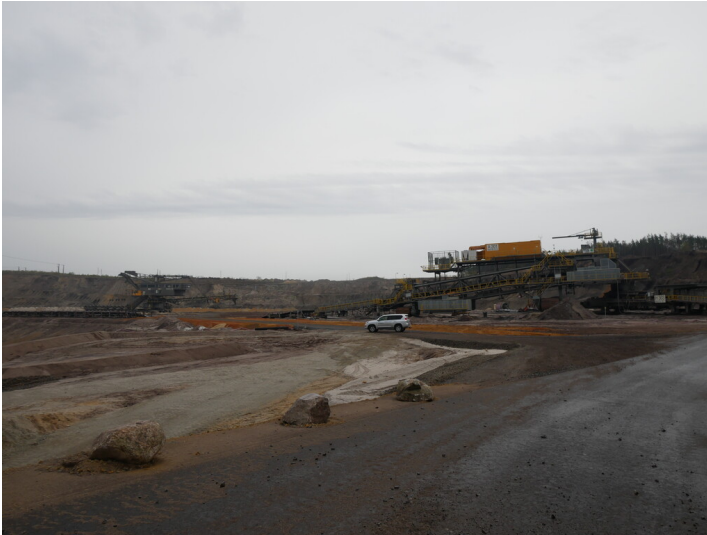
Eimerkettebagger ERs 710 348 Fotograf/Urheber: Tanja Trittel
