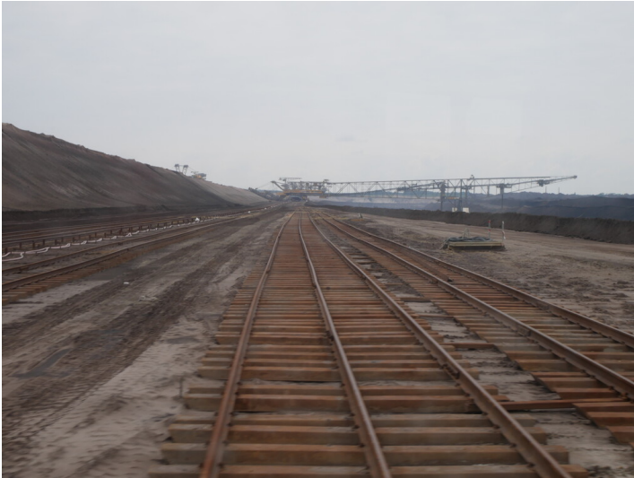
Fahrgleise Abraumpföhrbrücke F60 Fotograf/Urheber: Louise Warnow
