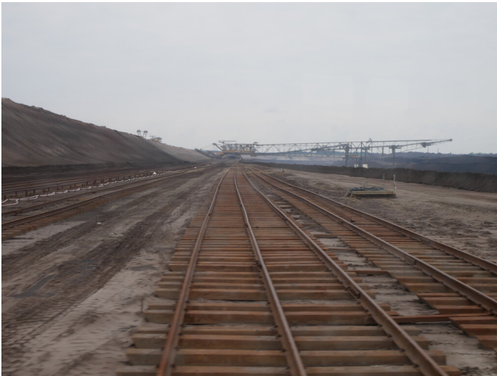
Fahrgleise Abraumförderbrücke F60 Fotograf/Urheber: Louise Warnow
