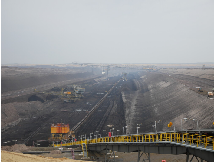
Bandanlage neue Kohleverladung Fotograf/Urheber: Tanja Trittel
