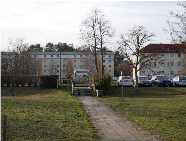
Wohngebiet II der Wohnungsbaugesellschaft Vetschau (WGV) Fotograf/Urheber: Dr. Barbara Kündiger
