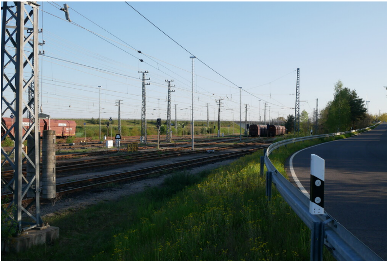
Kohlebahnanschluss Kraftwerk Jänschwalde Fotograf/Urheber: Kaja Boelcke
