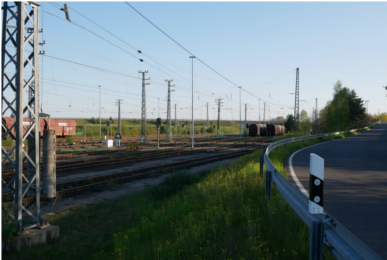
Kohlebahnanschluss Kraftwerk Jänschwalde Fotograf/Urheber: Kaja Boelcke
