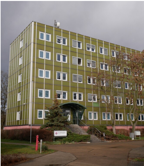
ORGREB-Institut für Kraftwerke Vetschau Fotograf/Urheber: Kaja Boelcke
