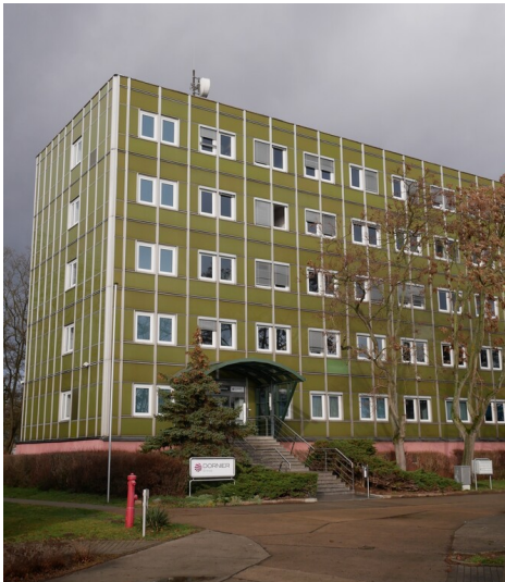
ORGREB-Institut für Kraftwerke Vetschau Fotograf/Urheber: Kaja Boelcke
