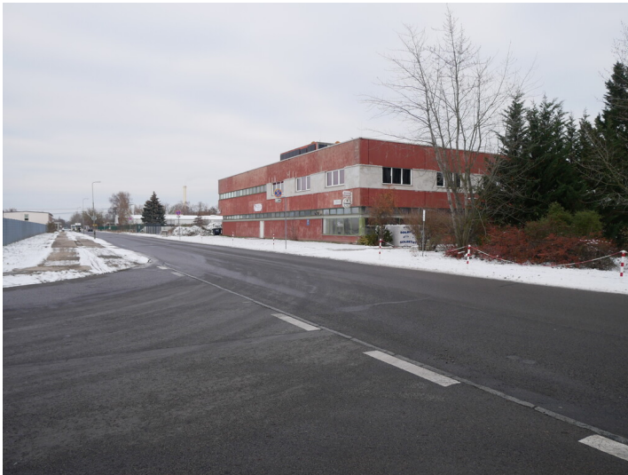
Betriebskantine Kraftwerk Lübbenau Fotograf/Urheber: Kaja Boelcke
