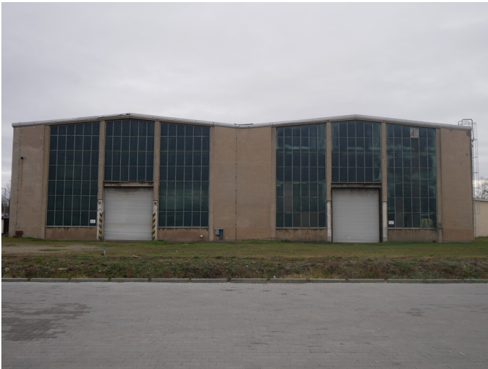
Gebäude der Hauptwerkstatt Kittlitz Fotograf/Urheber: Dr. Barbara Kündiger
