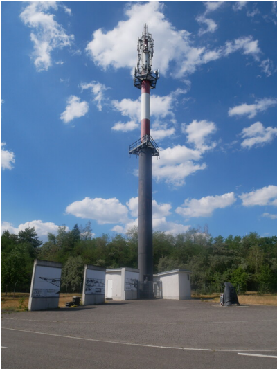
Funkturm Lausitzring Fotograf/Urheber: Franz Dietzmann
