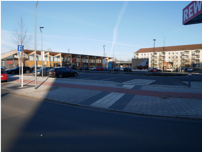
Großwohnsiedlung Neustadt Fotograf/Urheber: Dr. Barbara Kündiger
