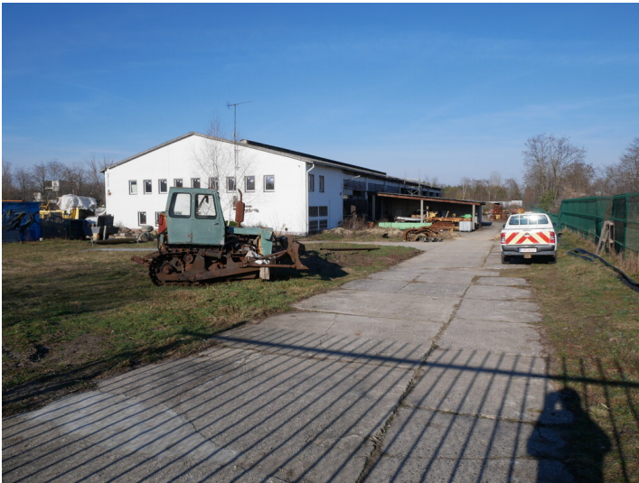
Fischzuchtanlage Kraftwerk Vetschau Fotograf/Urheber: Franz Dietzmann
