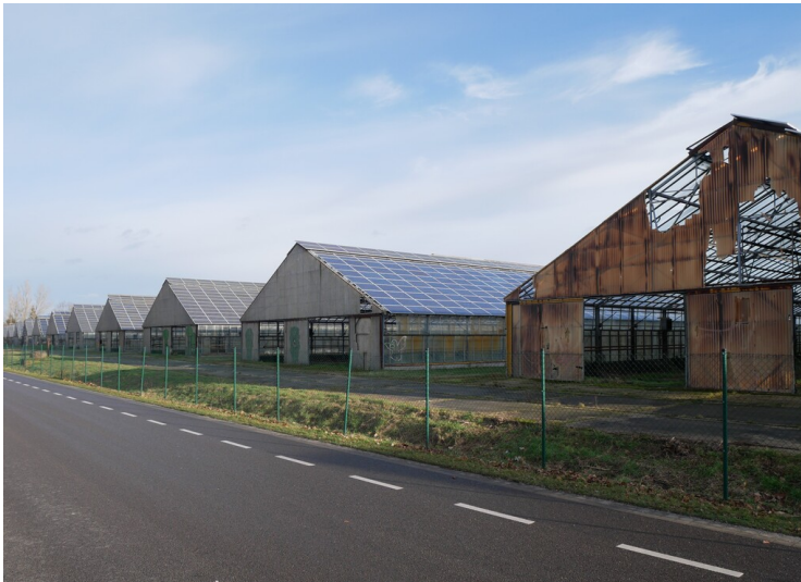
Gewächshäuser Kraftwerk Vetschau Fotograf/Urheber: Dr. Barbara Kündiger
