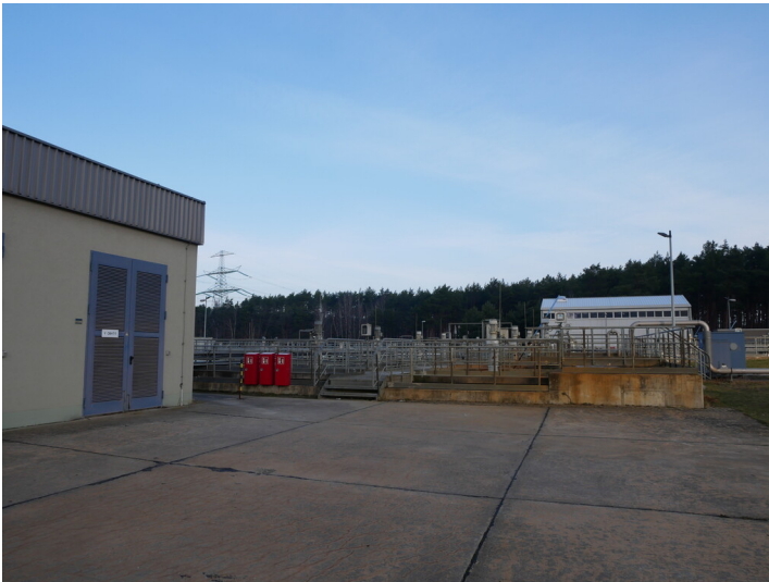
Kraftwerk Jänschwalde Grubenwasserreinigungsanlage (2022) Fotograf/Urheber: Tanja Trittel
