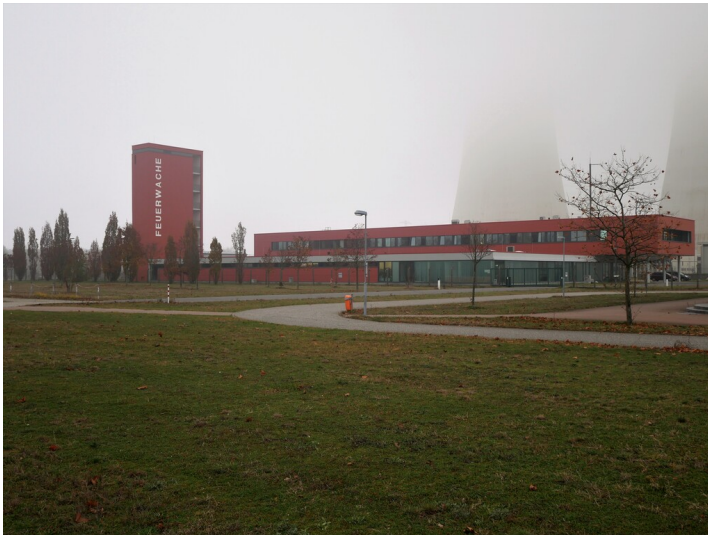
Neue Feuerwehr Kraftwerk Jänschwalde Fotograf/Urheber: Kaja Boelcke
