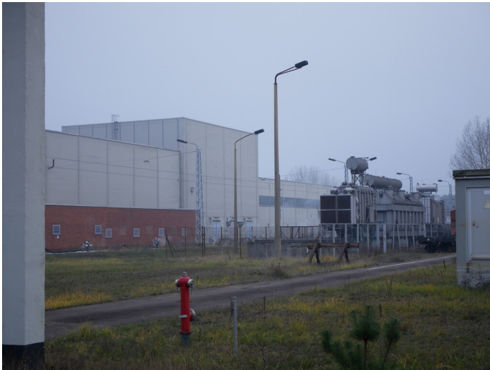
Heizölversorgung Kraftwerk Jänschwalde (2022) Fotograf/Urheber: Alexandra Krug
