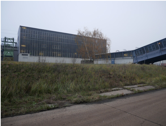
Übergabestation Kraftwerk Jänschwalde (2022) Fotograf/Urheber: Kaja Boelcke
