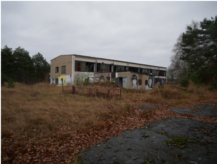
Umspannwerk Tagebau Schlabendorf-Seese Fotograf/Urheber: Dr. Barbara Kündiger
