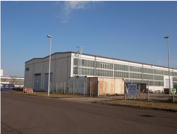
Kraftwerk Jänschwalde Instandhaltung (2023) Fotograf/Urheber: Tanja Trittel
