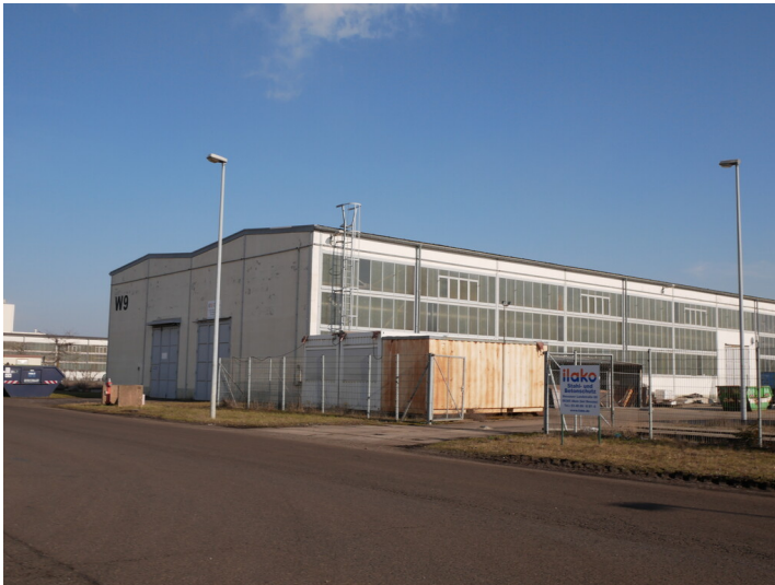
Kraftwerk Jänschwalde Instandhaltung (2023) Fotograf/Urheber: Tanja Trittel
