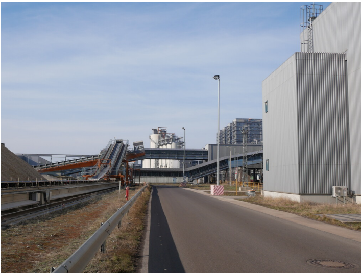
Kraftwerk Jänschwalde Kalksteinentladung (2023) Fotograf/Urheber: Tanja Trittel
