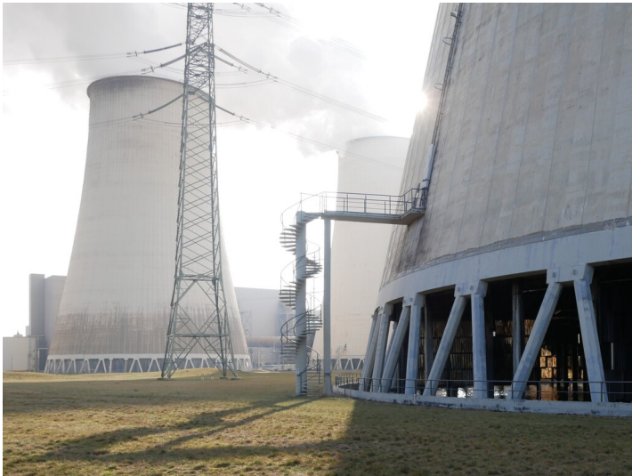
Kraftwerk Jänschwalde Kühltürme (2022) Fotograf/Urheber: Tanja Trittel
