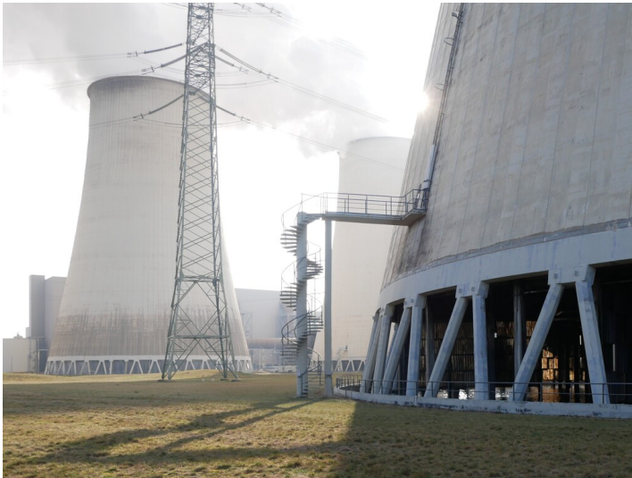
Kraftwerk Jänschwalde Kühltürme (2022) Fotograf/Urheber: Tanja Trittel
