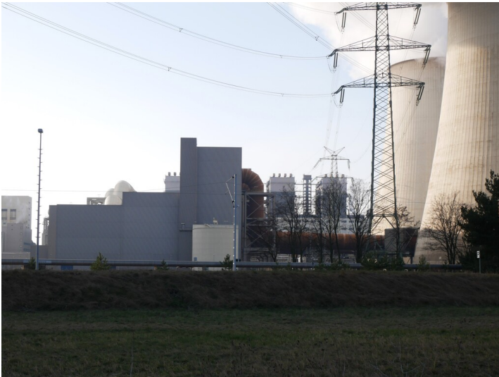
Kraftwerk Jänschwalde Rauchgasentschwefelung (2023) Fotograf/Urheber: Tanja Trittel
