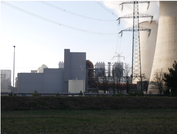
Kraftwerk Jänschwalde Rauchgasentschwefelung (2023) Fotograf/Urheber: Tanja Trittel
