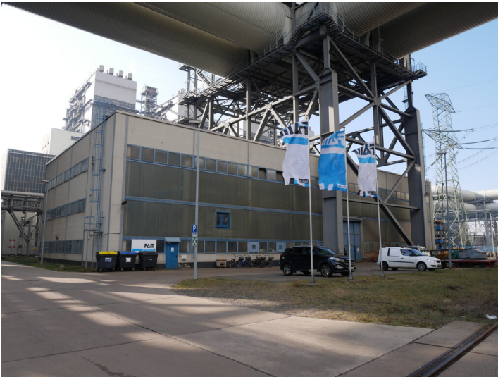
Kraftwerk Jänschwalde Montagehallen (2023) Fotograf/Urheber: Tanja Trittel
