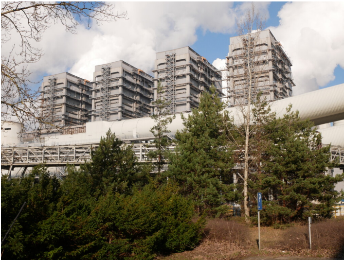
Kraftwerk Jänschwalde Kesselhäuser (2023) Fotograf/Urheber: Tanja Trittel
