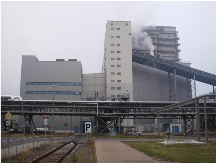
Kraftwerk Jänschwalde Bunkerschwerbau (2022) Fotograf/Urheber: Kaja Boelcke
