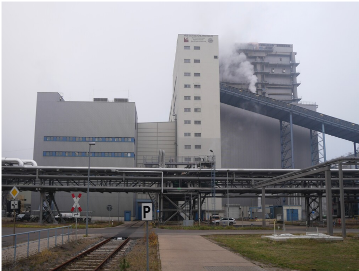
Kraftwerk Jänschwalde Bunkerschwerbau (2022) Fotograf/Urheber: Kaja Boelcke
