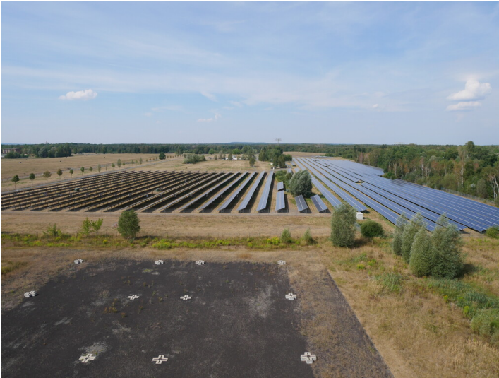
Photovoltaikanlage Lauchhammer Fotograf/Urheber: Stephan Redecker
