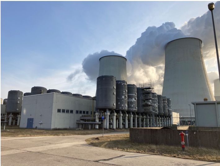
Kraftwerk Jänschwalde Kühl- und Kesselwasseraufbereitung (2023) Fotograf/Urheber: Tanja Trittel
