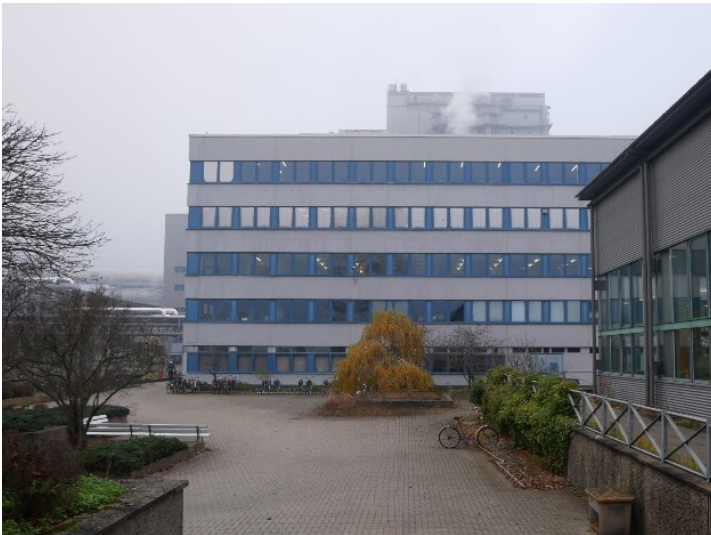
Kraftwerk Jänschwalde Betriebsgebäude Fotograf/Urheber: Kaja Boelcke
