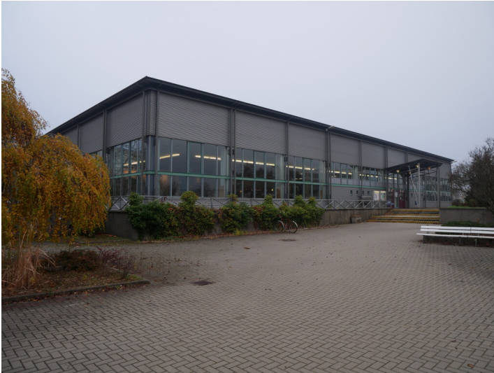
Kraftwerk Jänschwalde Kantine (2022) Fotograf/Urheber: Kaja Boelcke
