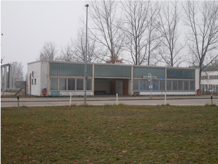
Buswartehalle Kraftwerk Jänschwalde Fotograf/Urheber: Kaja Boelcke
