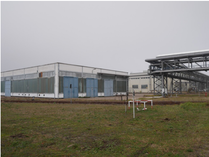
Kraftwerk Jänschwalde Fuhrpark (2022) Fotograf/Urheber: Kaja Boelcke
