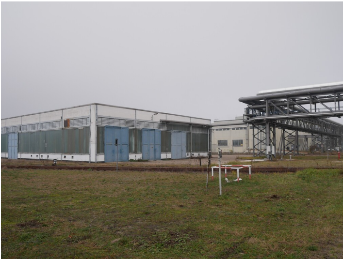
Kraftwerk Jänschwalde Fuhrpark (2022) Fotograf/Urheber: Kaja Boelcke
