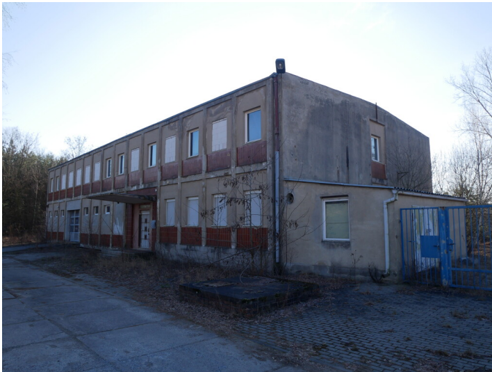
Kraftwerk Vetschau Fotograf/Urheber: Franz Dietzmann
