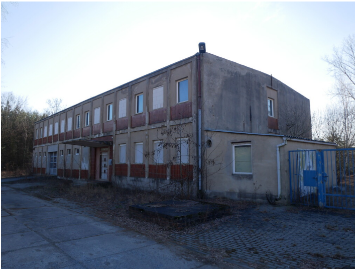
Kraftwerk Vetschau Fotograf/Urheber: Franz Dietzmann
