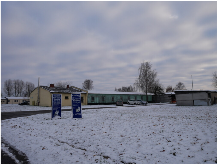
Baracken Kraftwerk Lübbenau Fotograf/Urheber: Kaja Boelcke
