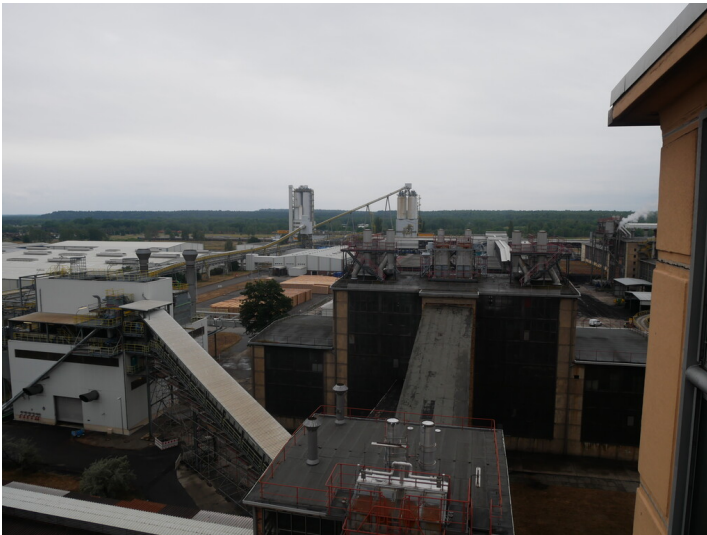
Mahlanlage West und Mahlanlage Ost Fotograf/Urheber: Franz Dietzmann
