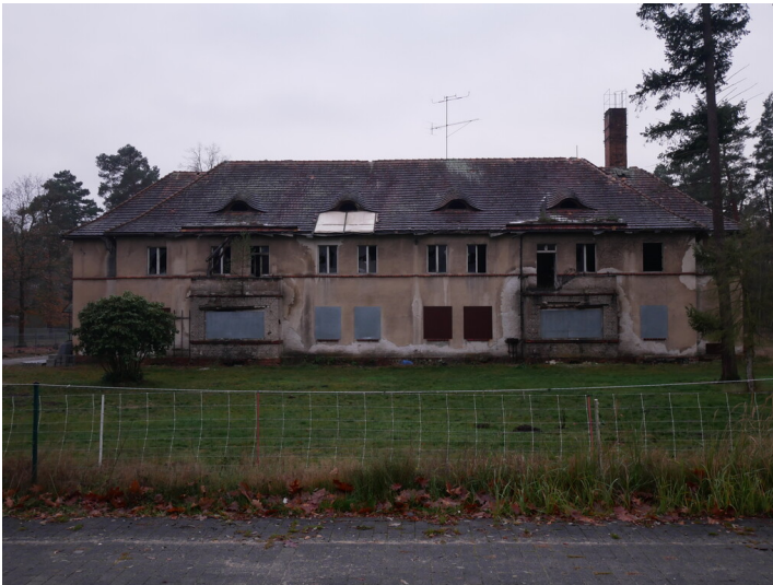
Wohnhäuser Brikettfabrik Brigitta Fotograf/Urheber: Kaja Boelcke
