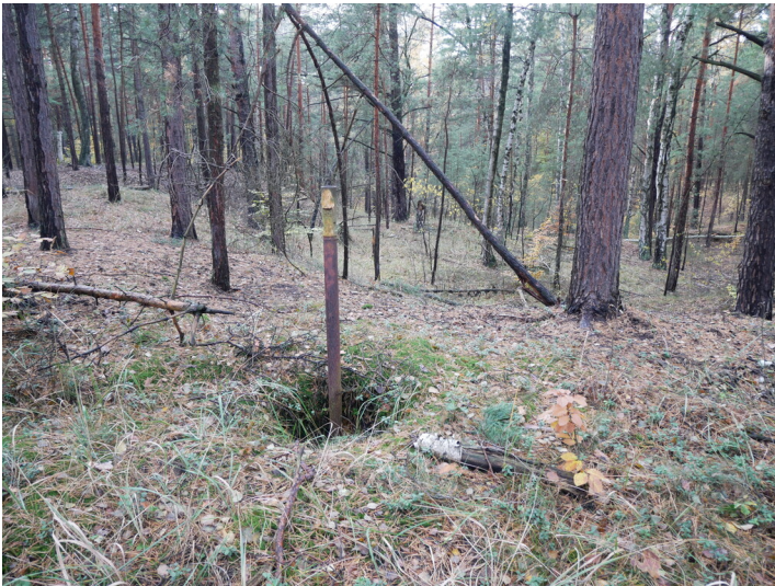
Bohrgestänge der Verfüllarbeiten Fotograf/Urheber: Franz Dietzmann
