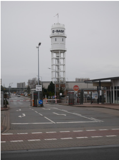
Wasserturm Fotograf/Urheber: Franz Dietzmann
