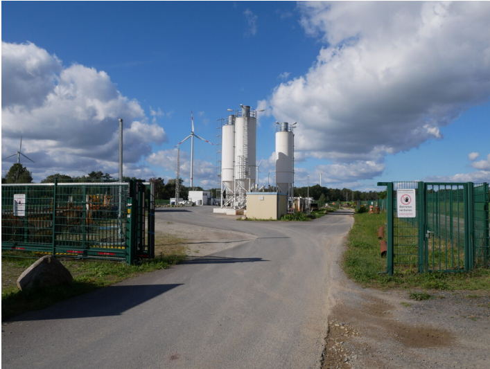
Dichtwandbaustelle Welzow-Süd Fotograf/Urheber: Kaja Boelcke
