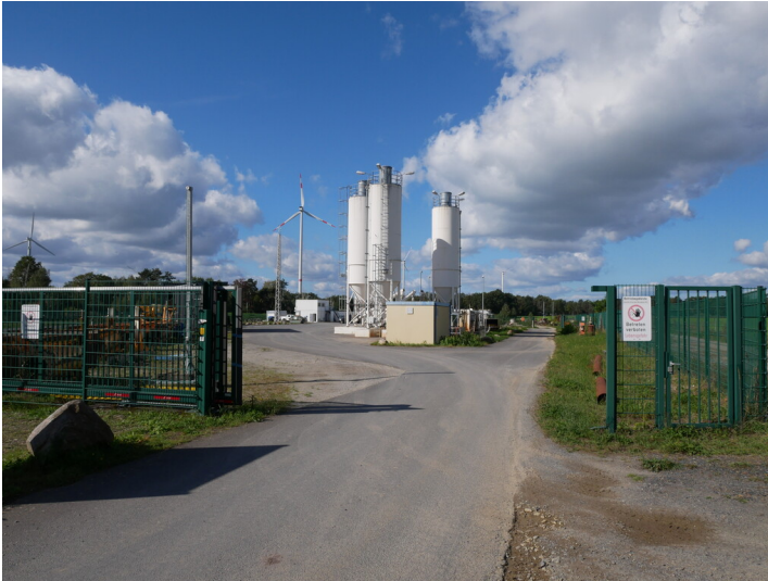
Dichtwandbaustelle Welzow-Süd Fotograf/Urheber: Kaja Boelcke
