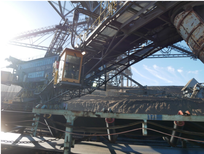
Eimerkettenbagger ERs 710 / 344 Fotograf/Urheber: Stefan Krug
