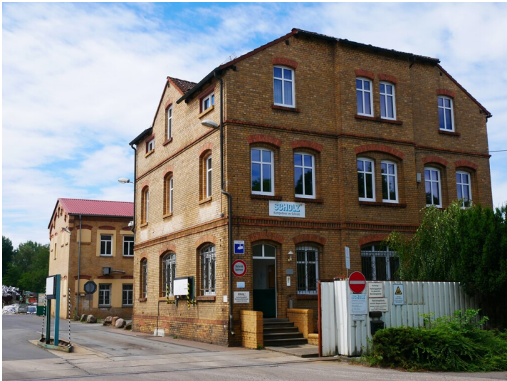
Gebäude Brikettfabrik Lauchhammer Fotograf/Urheber: Kaja Boelcke
