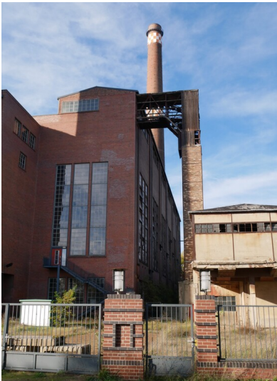
Conveyer Kraftwerk Plessa Fotograf/Urheber: Kaja Boelcke
