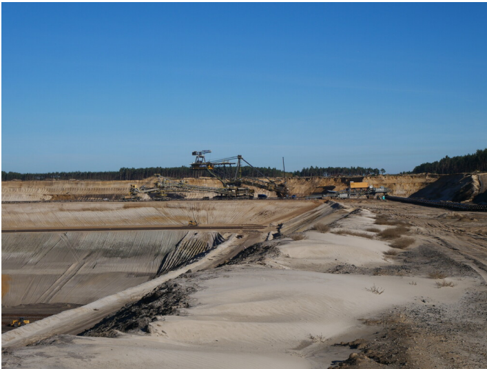
Schaufelradbagger SRs 2000 / 1557 Fotograf/Urheber: Stefan Krug
