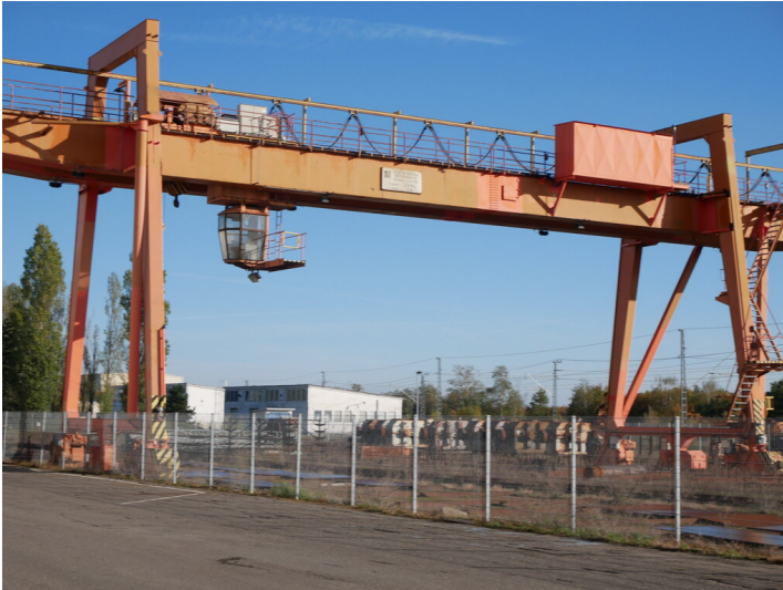
Portalkran Fotograf/Urheber: Franz Dietzmann
