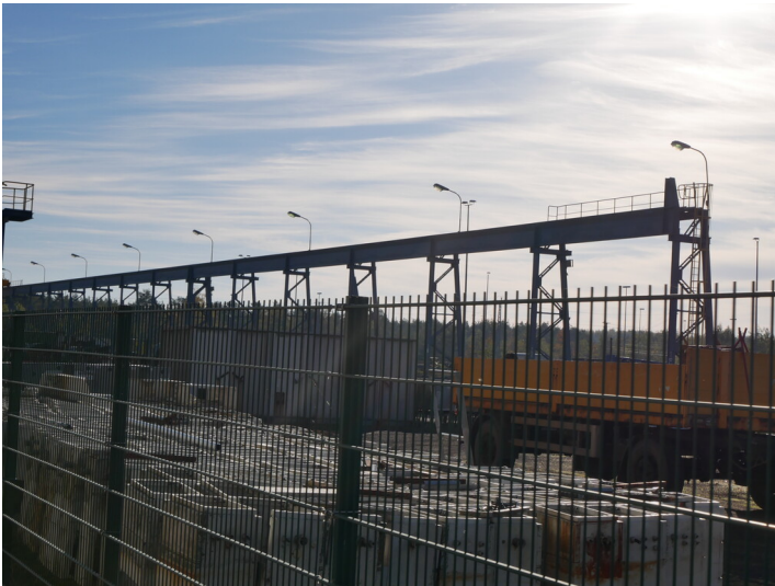
Kranbahn Fotograf/Urheber: Stefan Krug
