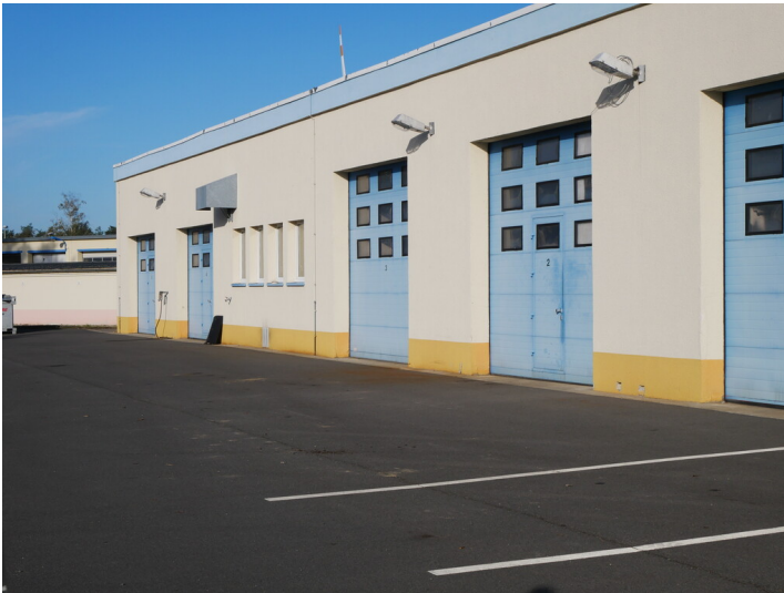
Garagen Fotograf/Urheber: Stefan Krug
