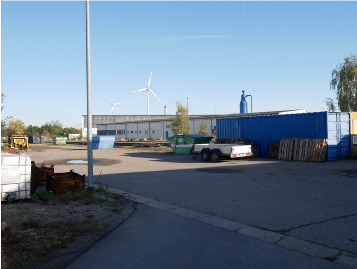
Halle Fotograf/Urheber: Franz Dietzmann
