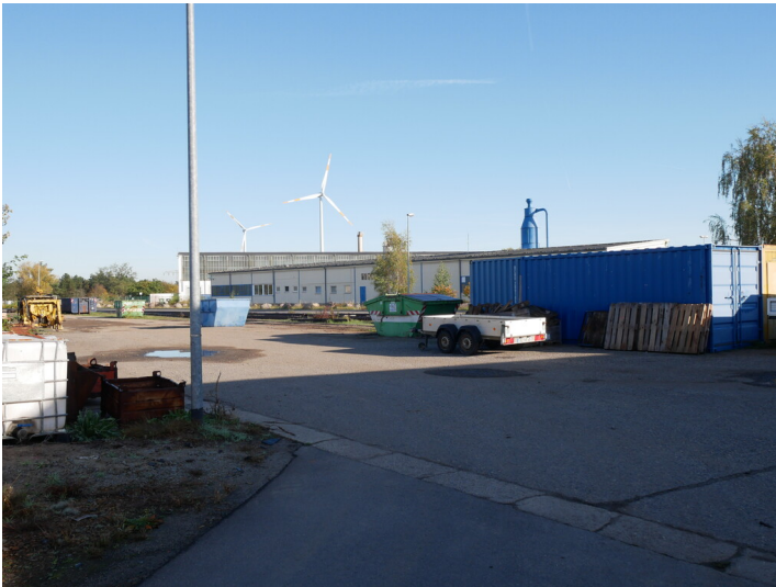
Halle Fotograf/Urheber: Franz Dietzmann
