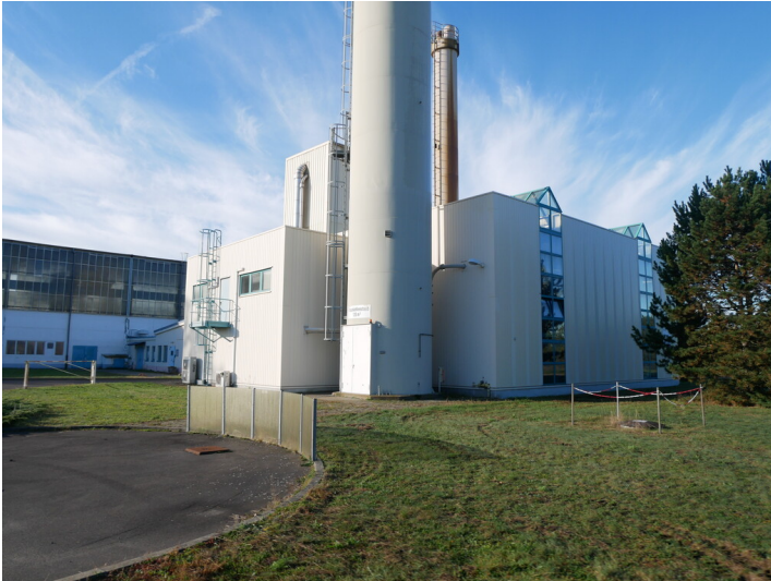
Heizhaus Fotograf/Urheber: Stefan Krug
